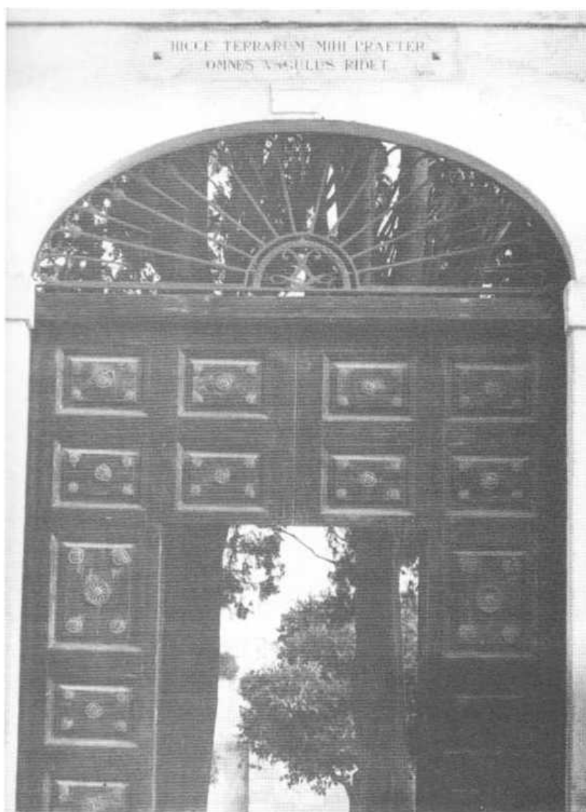
III. 14. - Facciata principale della Villa di Leucaspide con l'annesso aranceto
